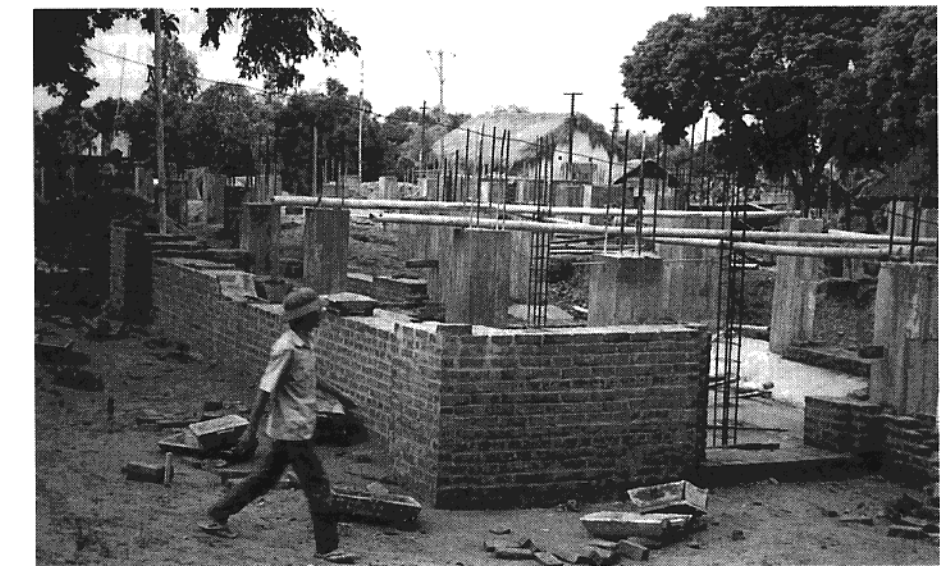
Le mur de la nouvelle église s'élève à 1m mais le chantier a dû être interrompu.
