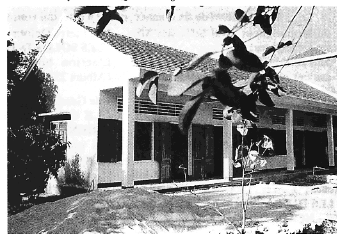
Bâtiment neuf terminé à Qui-Nhon grâce à l'ANAI.
