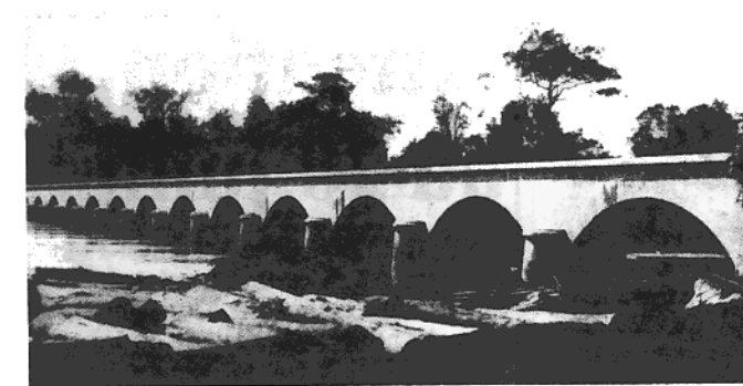
► Pont de chemin de fer de transbordement des chutes de Khône. Le Laos qui n'a pas de voie ferrée, a un magnifique pont de chemin de fer, de 158 mètres de long, qui relie deux îles dans la région des chutes de Khône. Le chemin de fer de transbordement n'avait que 4,5 kilomètres de long lorsqu'il fut construit en 1893. Il en avait 7 kilomètres grâce au pont construit entre 1916 et 1919. Il n'est plus en service depuis 1940.
