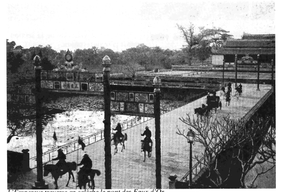
L'Empereur traverse en calèche le pont des Eaux d'Or.
