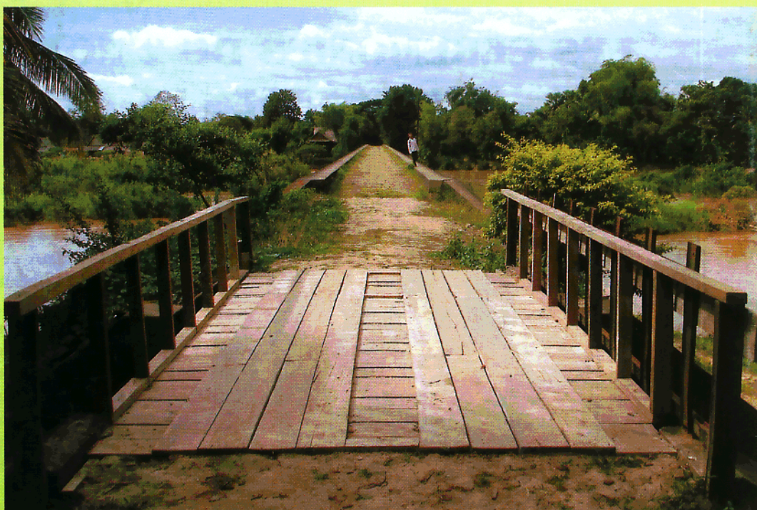
Passerelle fabriquée avec des rails.
