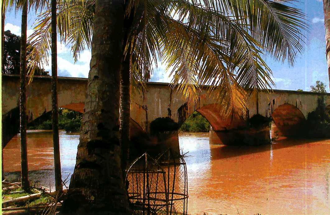
Pont entre les deux îlots.
