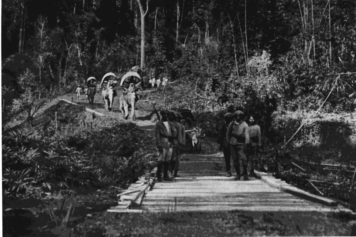
En 1932, construction d'une piste automobile en pays Moï insoumis (L'Illustration du 12/11/1932).
