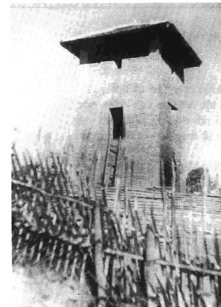
La tour de garde K 31.
